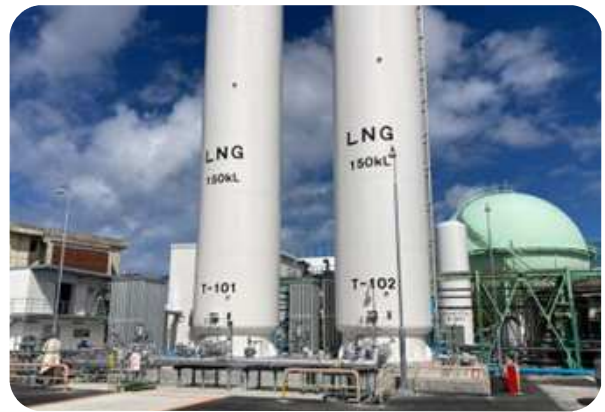
LNGガス貯槽設置工事
