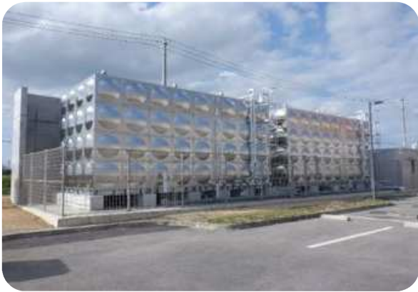
災害拠点病院受水槽工事
