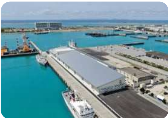
沖縄県高度衛生管理型荷捌施設
